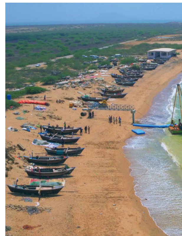
中电胡布渔民码头建设现场
