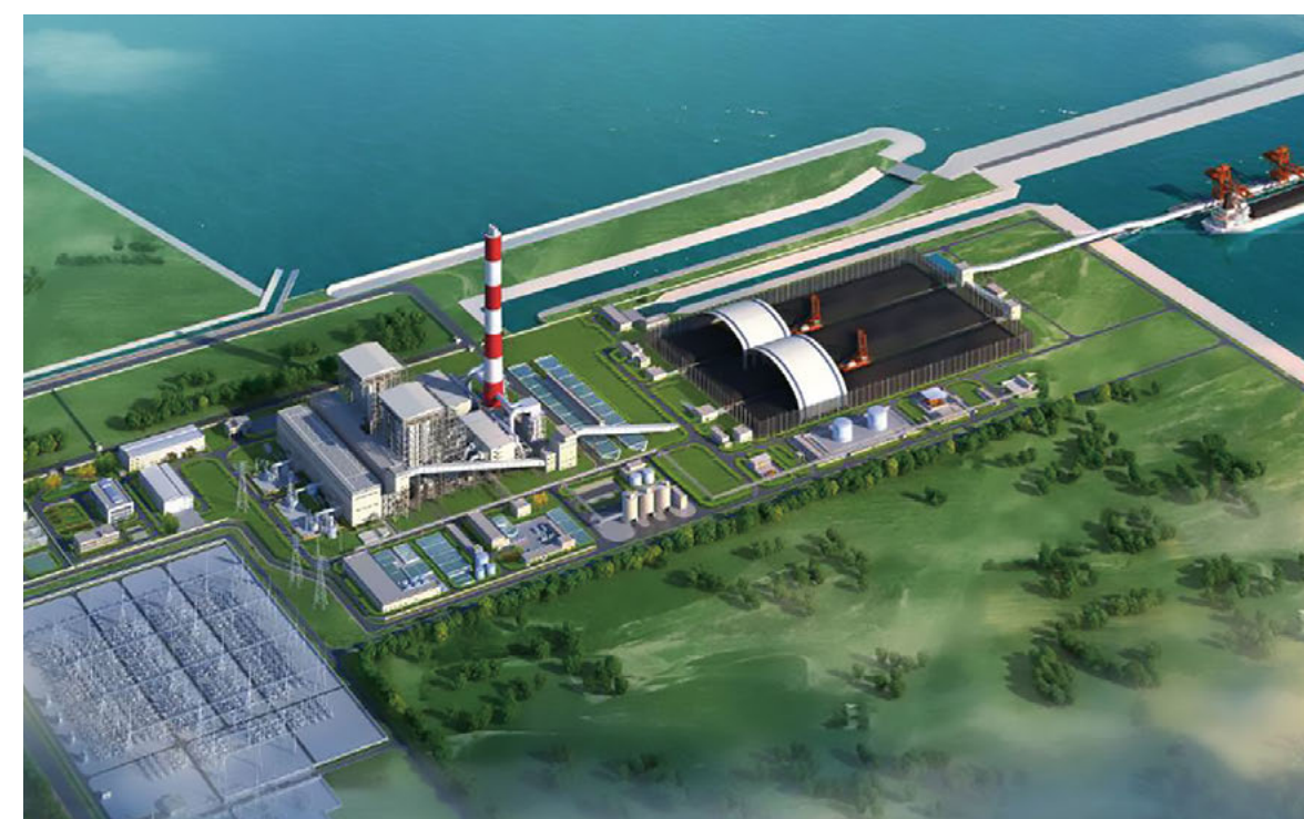
越南永新燃煤电厂一期项目
