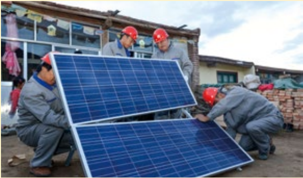
在青海省兴海县子科滩乡清根河村，中国大唐技术人员正在为无电用户安装户用电源
