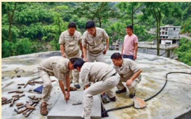
中国大唐扶贫干部与村干部、群众检查安兰村饮水工程建设及使用情况
