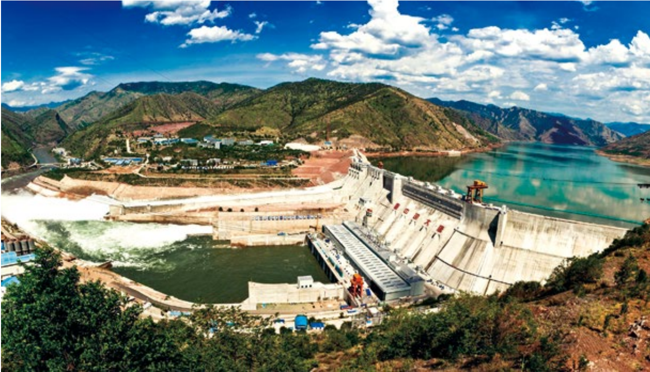
全国首个电力安全生产标准化一级水电工程建设项目——大唐观音岩水电站
