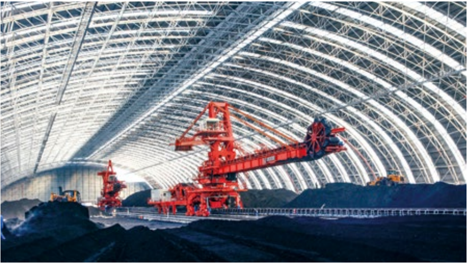
大唐滨州发电公司封闭式煤场
