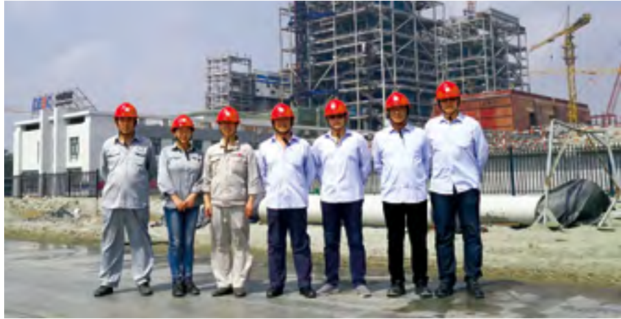
▲ 孟加拉帕亚拉 2 台 66 万千瓦超超临界燃煤机组 5 年期运维项目作为“一带一路”倡议在孟加拉落地的旗舰项目，标志海外高端技术运维市场实现新突破。该电站是孟加拉第一个超超临界机组电站，也是在建装机最大、等级最高的火电项目
