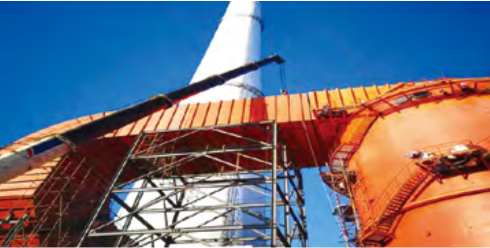
大唐桂冠合山发电公司 3 号机组超低排放改造工程
