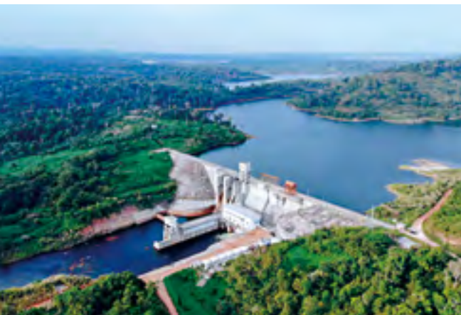
▲ 柬埔寨斯登沃代水电站全年安全稳定运行，2019 年发电总量 1.86 亿千瓦时，创造了良好的效益
