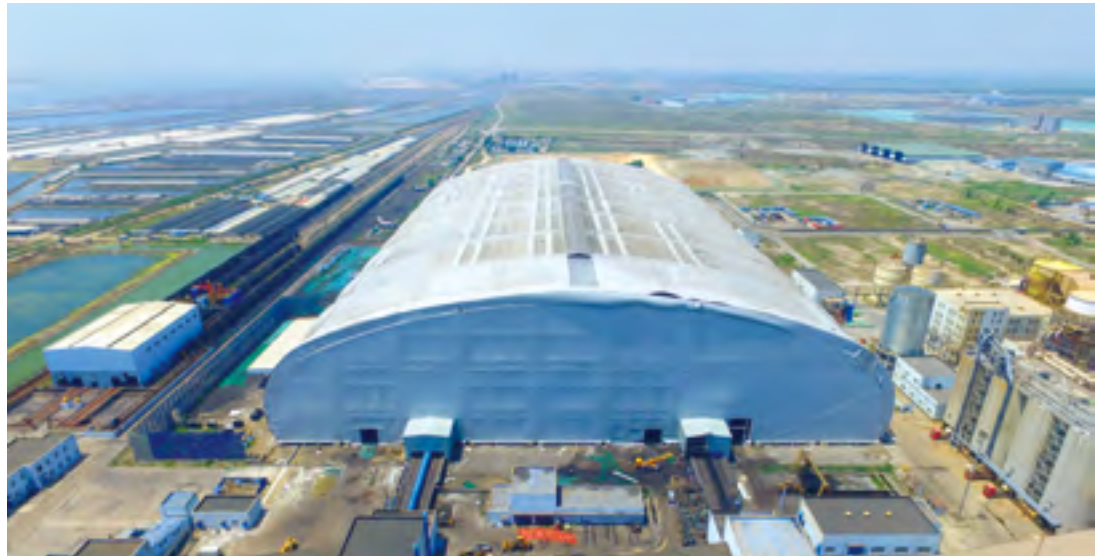
▲ 2019 年 6 月 28 日，亚洲最大跨度封闭煤场——河北大唐国际王滩发电有限公司 2 台 60 万千瓦机组封闭煤场正式投入运行。该项目采用单拱单跨桁架膜结构，中间不设立柱，东西跨度 288 米、南北跨度 211 米、顶部高度 59 米。机组投产后彻底消除了煤场扬尘，具有巨大的社会效益和环保效益
