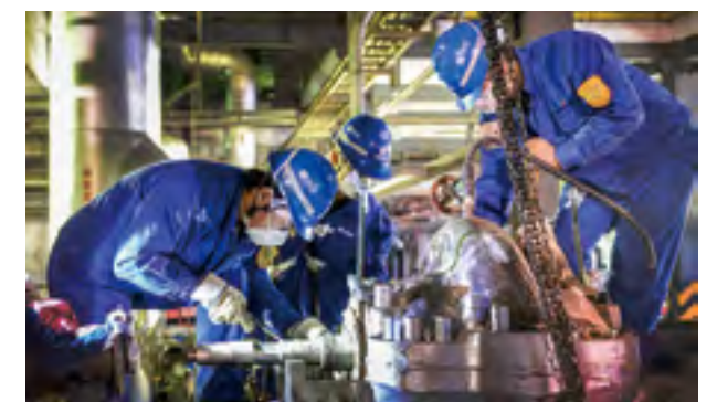
▲ 疫情期间进行生产设备检修
