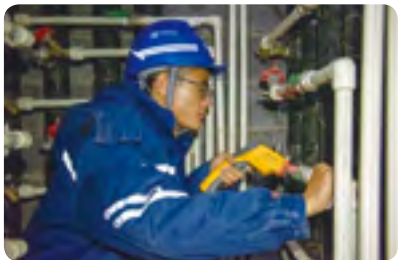
▲ 辽宁分公司党员突击队为保供热，奋战在“急难险重”工作一线
