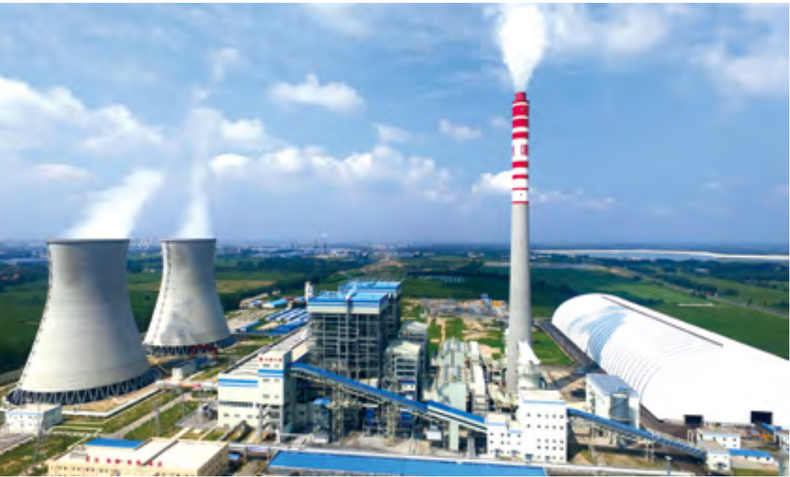
◀ 大唐山东临清热电公司“上大压小”新建项目荣获 2018-2019 年度国家优质工程奖，该项目建设 2 台 35 万千瓦“上大压小”超临界热电联产燃煤机组，项目投产后顺利关停聊城市辖区内 6 家企业共计 14 台、总容量 23.1 万千瓦小火电机组，拆除供热区域内 34 台分散供热小锅炉，具有较好的经济效益、环保效益和社会效益
