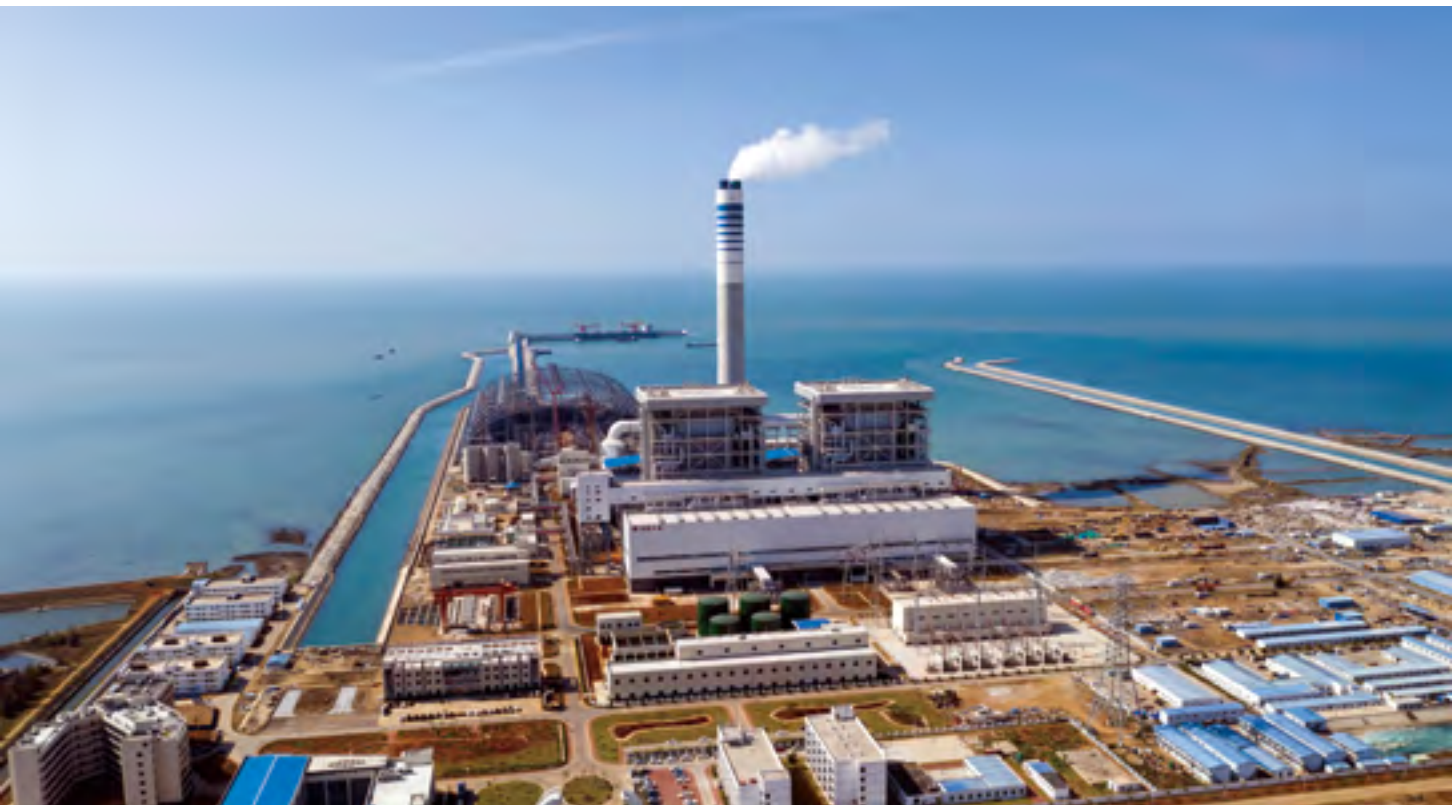
▲ 2019 年 12 月 7 日，广东大唐国际雷州发电公司“上大压小”新建工程 1 号机组通过 168 小时试运行。项目投产后，在额定工况下，机组供电煤耗将达到 265.91 克/千瓦时，与同容量高效一次再热机组相比，每年可节约燃煤约 7.48 万吨，减少排放二氧化碳约 20.6 万吨、二氧化硫约 23.3 吨。该机组是中国大唐首台二次再热百万千瓦机组，也是广东省首次投产同类机组
