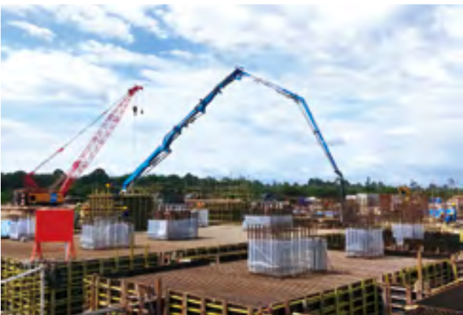
▲ 印尼米拉务 2 台 22.5 万千瓦燃煤发电项目工程建设现场
