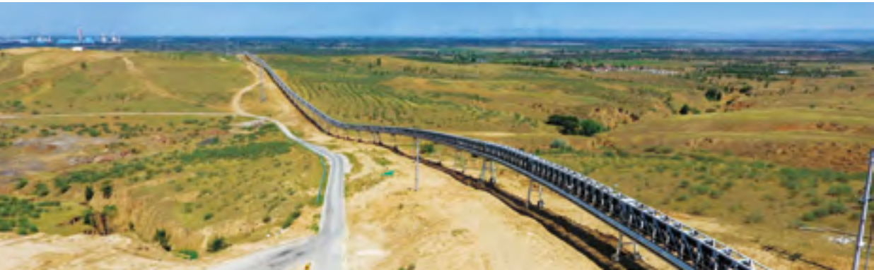
内蒙古大唐国际托克托发电公司圆图兔沟小流域综合治理项目
