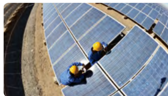
▲ 青海格尔木光伏电站员工检修设备
