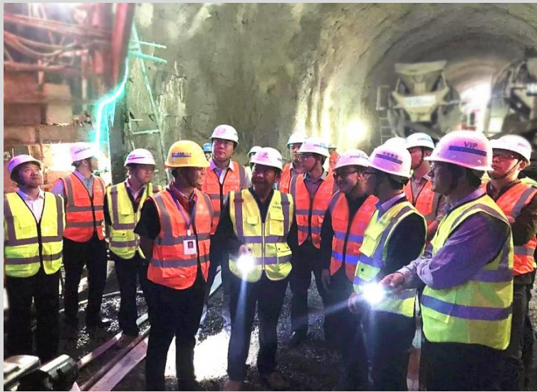
云南都香 A4 项目安全管理检查现场
