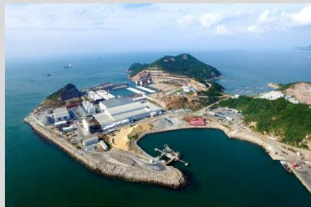
深中通道施工现场
