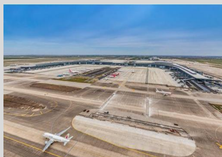
上海浦东机场三期扩建工程
