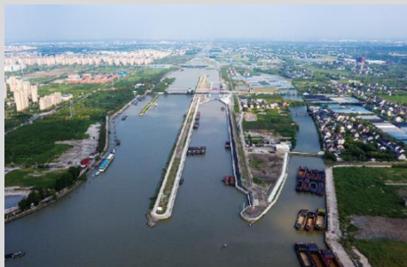
上海大治河西枢纽新建二线船闸
