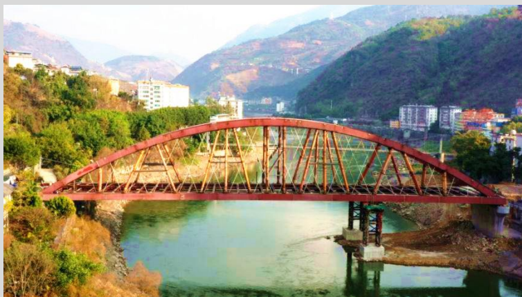
公司援建怒江州泸水市“中交怒江连心桥”项目（在建）
