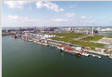
盘锦港荣兴港区 305 号高桩码头
