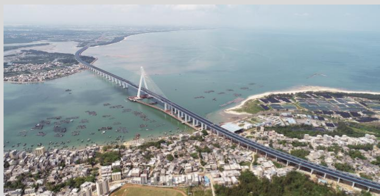
海南海文大桥
