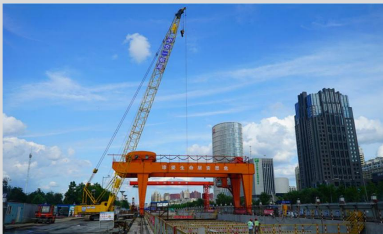
丁香公园站施工
