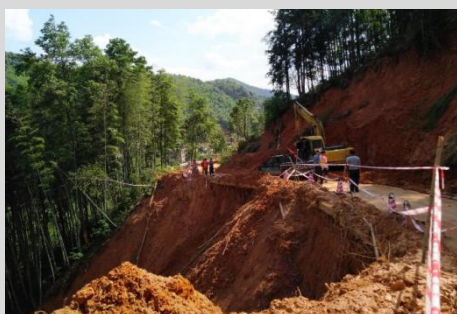
铁道总院参与河源市龙川县 “6·10”洪灾抢险
