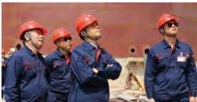
中国航油党委常委、副总经理龚丰赴北京大兴国际机场航油工程现场检查指导
