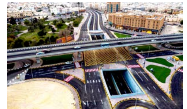
中国石化承建的达曼28号街通道立交桥项目，彻底解决该路段拥堵问题，车辆通过该区域从原来几小时缩短至5分钟
