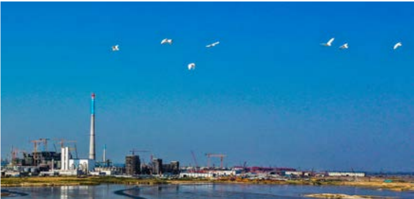
中国石化天然气分公司负责建设的中科炼化一体化工程配套输气管道—— 通明海峡定向钻穿越工程紧邻红树林一级自然保护区和大片海产养殖基地。在建设过程中，公司邀请国内专家多次进行技术论证，组织技术攻关，对泥浆等施工材料均采用环保配比，全力保护通明湾海峡生态环境健康稳定
