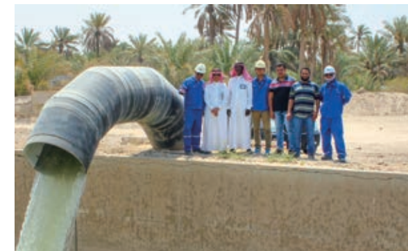
中国石化承建的沙特农业部净化水输水工程正式建成投用，惠及该区域逾100万人，每天输送的净化水已经成为哈撒绿洲地区灌溉用水的重要补充
