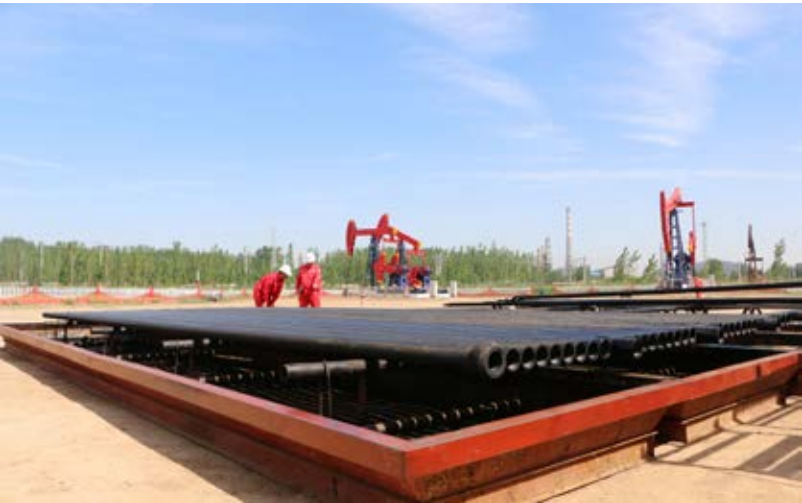
中国石化胜利油田全面推行修井现场环保围堰，从源头减少固体废物的产生，避免产生二次污染，提升作业现场清洁生产 and 环境风险控制水平，年减少危险废物1.1万吨
