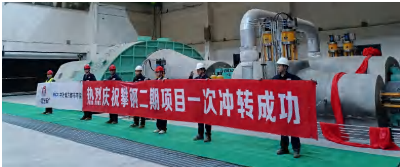
攀钢钒能动分公司100兆瓦余热余能利用发电二期工程建成后，每年可有效减少二氧化碳排放8万吨以上
