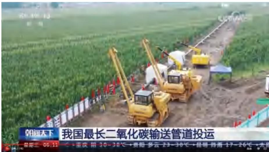
► 低温高韧性 L360Q 管线应用于中石化“齐鲁石化-胜利油田”百万吨级 CCUS 项目。
