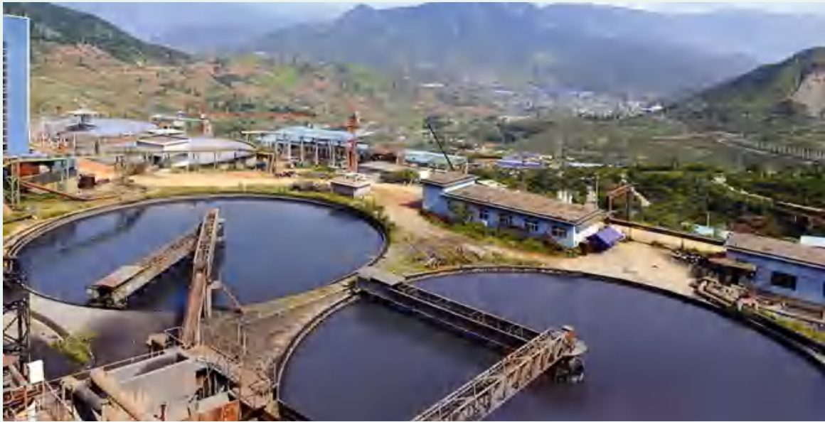
攀钢矿业新白马公司浓缩池
