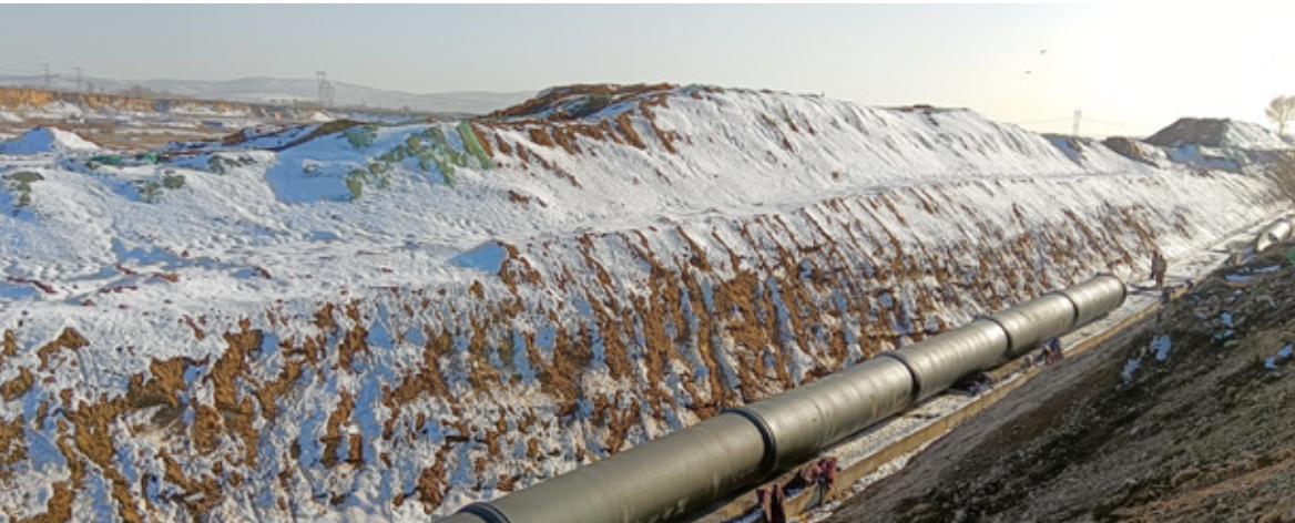
新兴铸管生产的球墨铸铁管应用于岱海生态应急补水工程
