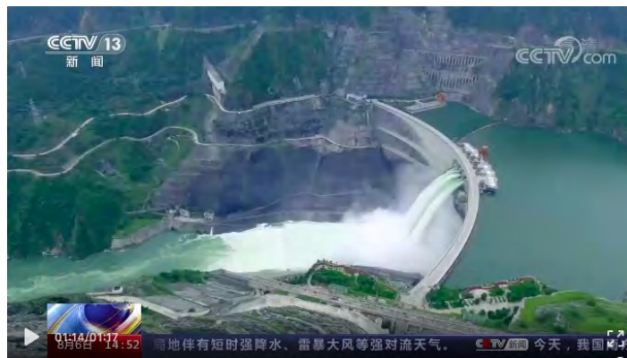
▲华能小湾水电站成功投运
