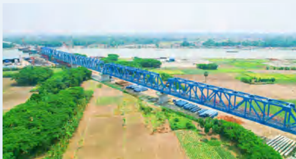
帕德玛大桥铁路连接线开通运营
