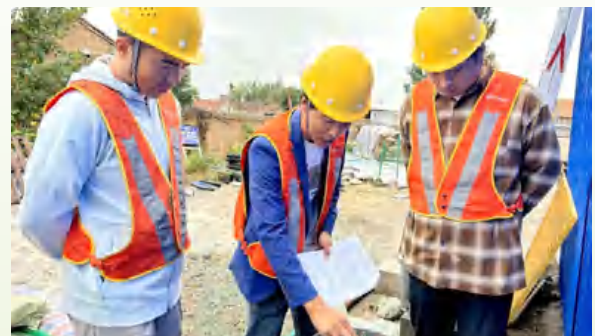
师父正在施工现场指导徒弟
