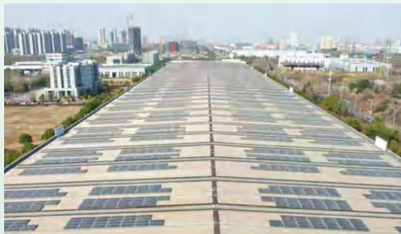
道岔联合厂房屋面光伏
