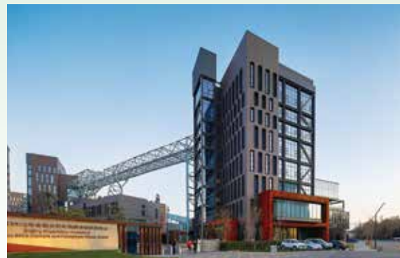
首钢冬奥组委指挥部调度中心
