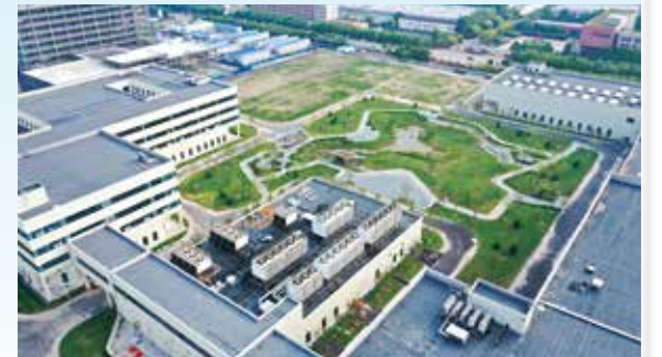
新能源汽车检验中心（天津）建设项目
