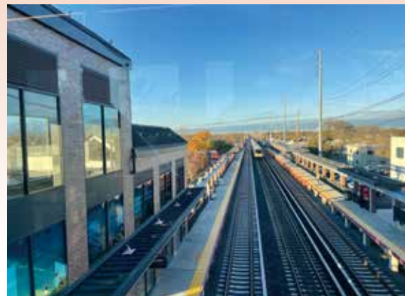
美国纽约长岛铁路改扩建项目
