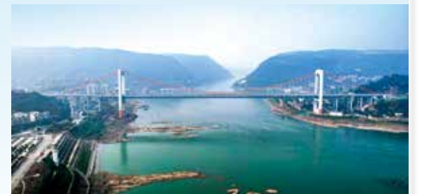
重庆郭家沱长江大桥项目
