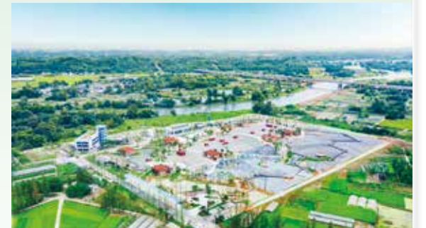
天府国际生物城污水处理厂项目
