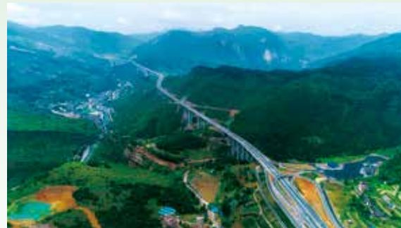
贵州正习高速公路项目
