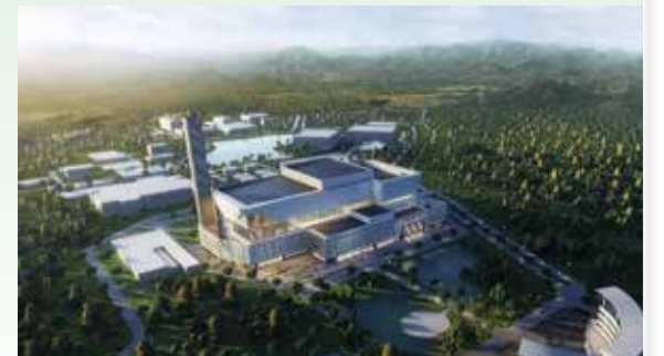
武汉千子山循环经济产业园生活垃圾焚烧发电 PPP 项目
