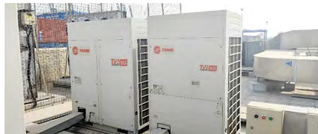
变制冷剂流量（VRF）空调系统
