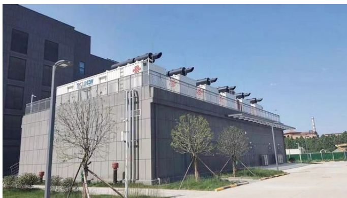
中国联通西北智云数据中心
