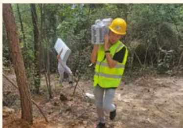
武隆贫困偏远山区基站建设
