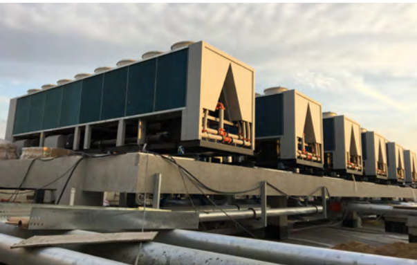
2020 年 1 月，安徽公司天都路数据中心机房风冷式冷水空调安装现场
