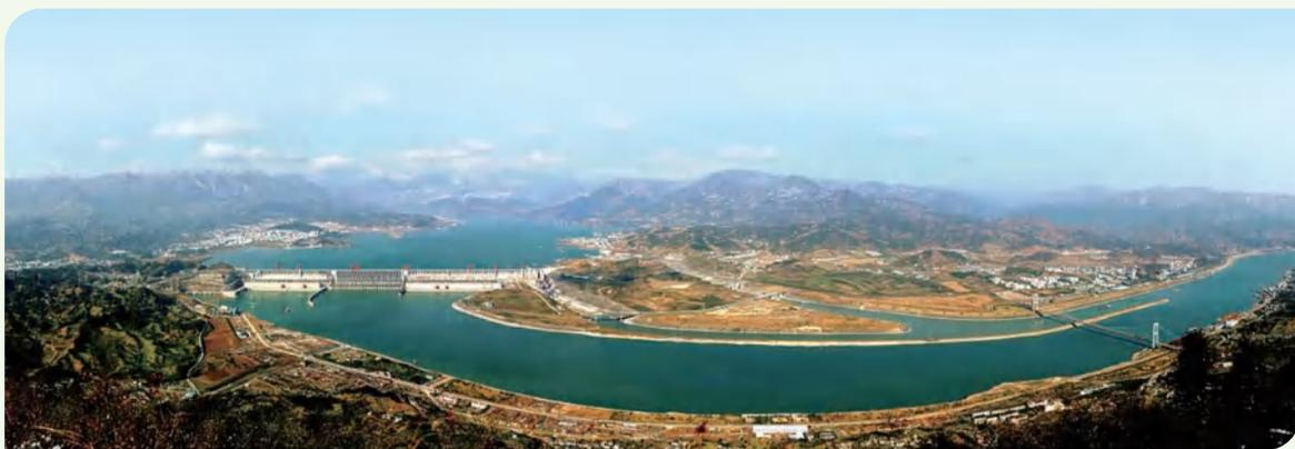
长江通道是我国国土空间开发最重要的东西轴线，在综合交通运输中占主导地位，在区域发展总体格局中具有重要战略地位。截至2011年底三峡过闸货运量突破1亿吨，超过设计通过能力，船闸通过能力严重不足，过闸船舶拥堵已成为常态，航运效率和服务水平严重下降，成为制约长江水运发展的瓶颈。
