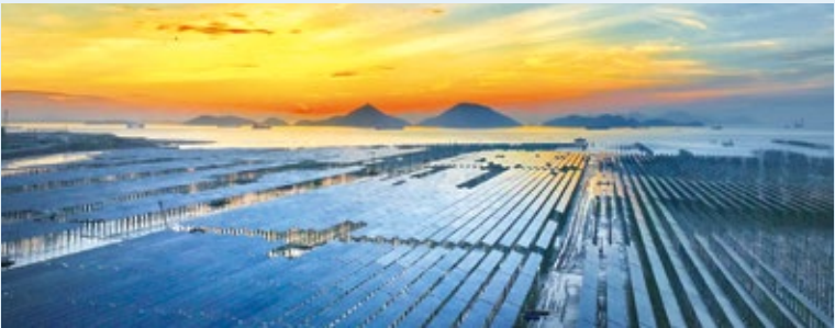
• 中核滩涂光伏项目
