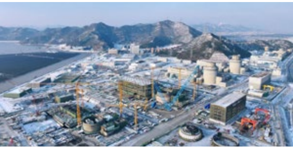
• 三门核电一期工程两台机组安全稳定运行，二期工程建设现场稳步推进
