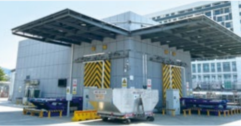
• 全球首台民用航空集装箱 CT 型（计算机断层扫描）爆炸物探测安全检查系统
