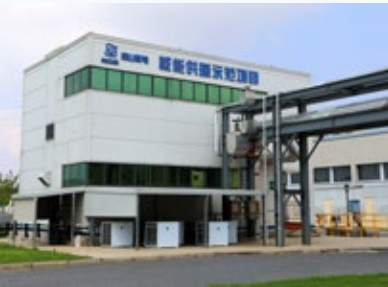
• 核能供暖换热首站外景
