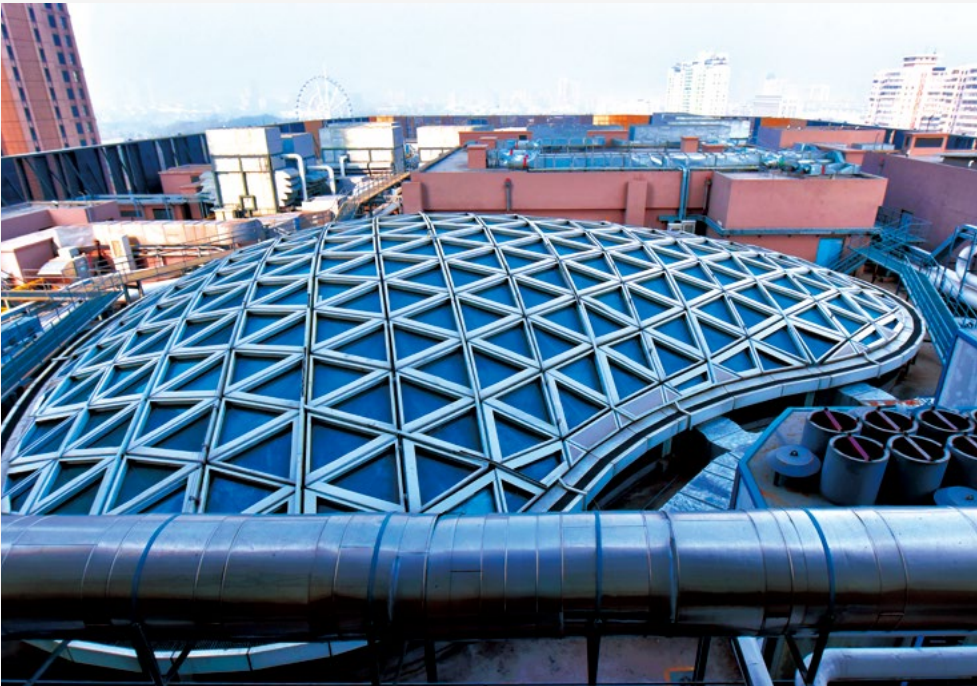
天津鲁能城绿荫广场屋顶的暖通空调部分设备机组
