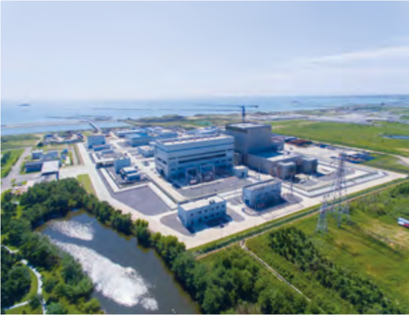
全球首座球床模块式高温气冷堆核电站——山东荣成石岛湾高温气冷堆核电站示范工程并网成功
