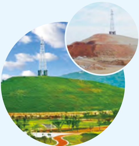
湖北黄石铁山——还地桥矿山项目修复前后
