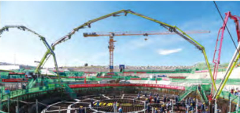
小堆示范项目在海南昌江核电现场正式开工
