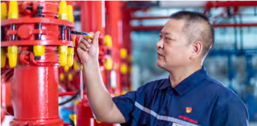
华侨城物业检查社区设施设备安全
