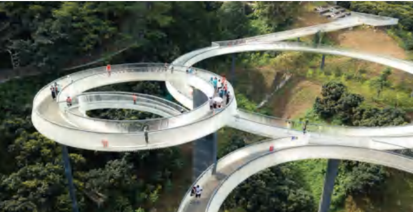
深圳光明小镇马拉松山湖绿道浮桥
