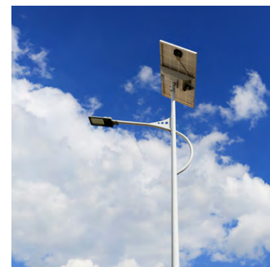
援建禄劝县屏山街道发明村太阳能路灯
