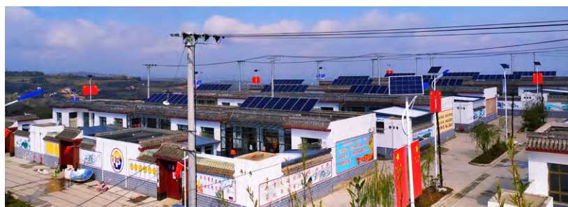
屋顶光伏发电项目
