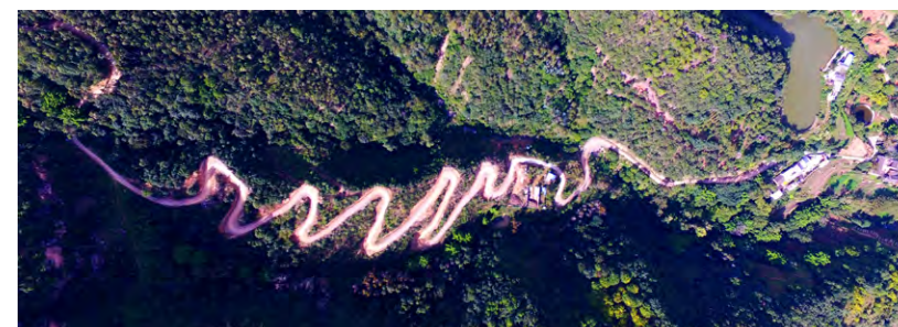
援建禄劝县屏山街道发明焦山村公路
