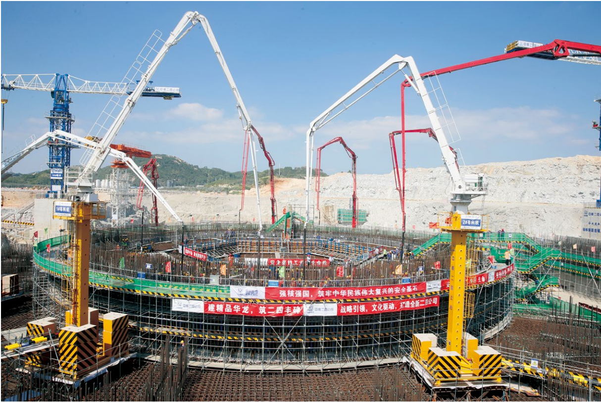
中核集团漳州核电正式开工
