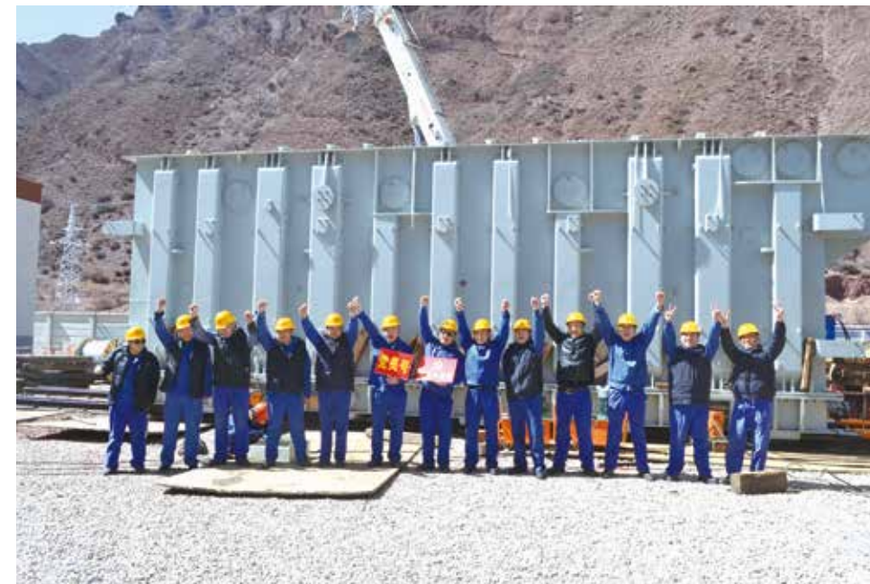
挑战极限完成西藏藏中联网变压器现场组装
