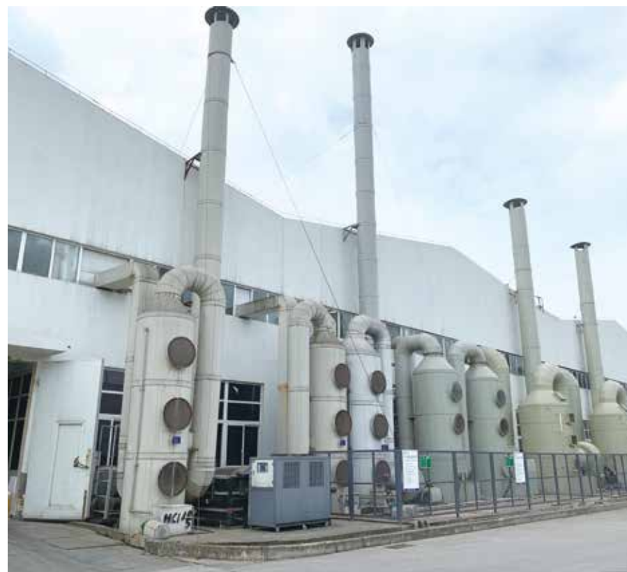
镀铬生产线铬酸雾净化塔自动处理系统
