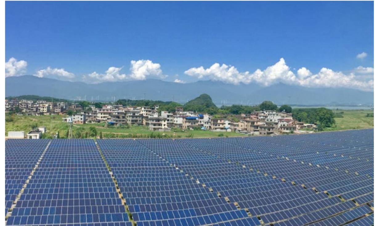
广西贺州华润循环经济产业示范区 6MW 太阳能光伏发电项目是华润电力在桂投资兴建的首个太阳能光伏发电项目，投资约 4400 万，建成后每年可为地区电网贡献 6000MWh 清洁电能，是示范区打造风、光、火多能互补综合能源供应基地的重要组成部分。
