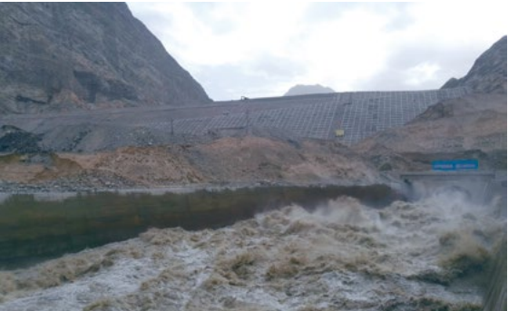
冰川堰塞湖洪水通过新疆阿尔塔什水利枢纽工程
